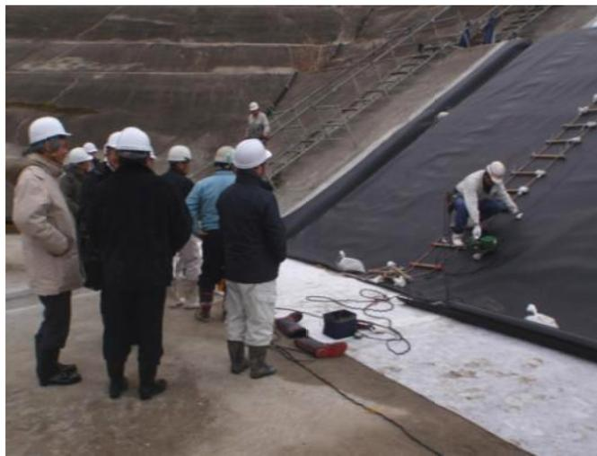
遮水シート溶着および加圧試験の確認
