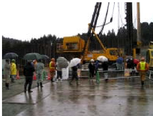
鉛直遮水壁工事中(CSM工法)の監視状況
