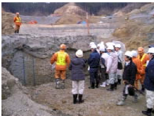
施工済み部分の鉛直遮水壁の監視状況
