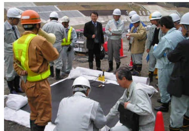
遮水シートの溶着後の確認検査
