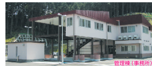
管理棟(事務所)
